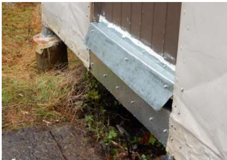
Above: New door sill & door angle flashing
